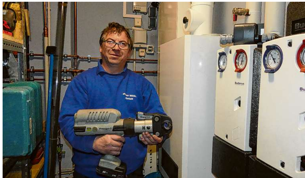
Marco Berndt-Koch zeigt eine Profi-Pressmaschine, mit der Wasserleitungen verbunden werden Foto: Rutke
